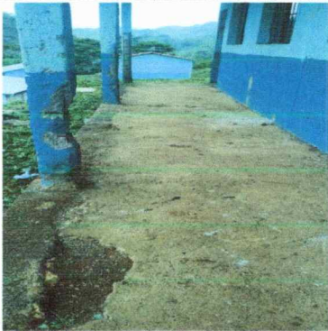
Foto 3: Sustitución de piso y columna
