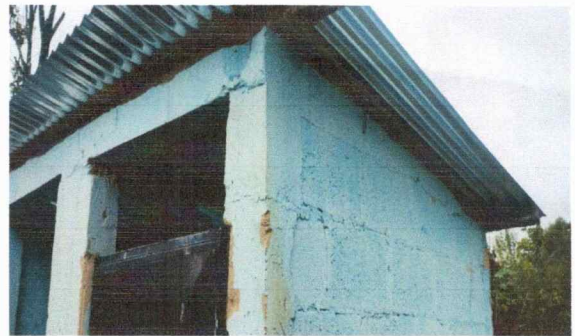
Foto 6: Las columnas de los sanitarios requiere reforzamiento ya que presenta un peligro
