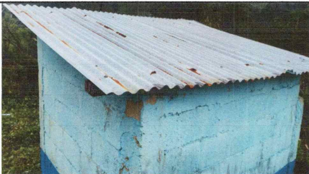
Foto 5: La estructura del techo y la cubierta de lamina requiere cambios
