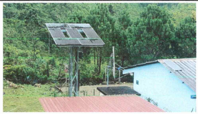
Foto 2: Reparación de sistema eléctrico
